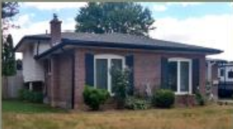
Maison à paliers
